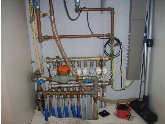
Gulvvarmesystem med direkte ledningsforbindelser uden automatik.
